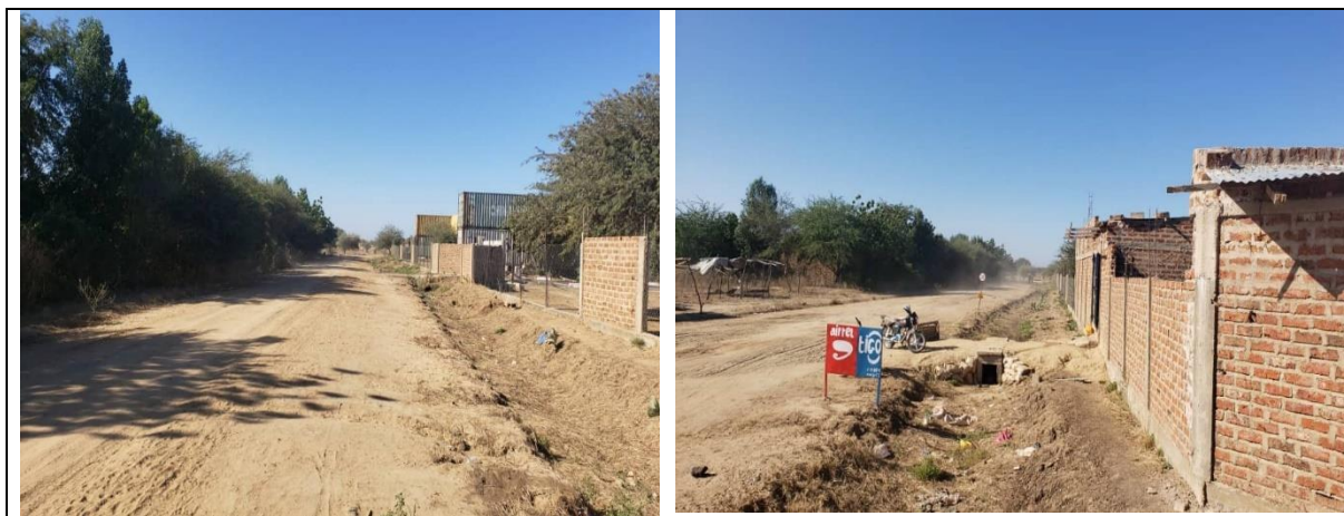
Figure 15 :: Route existante non bitumée avec les clôtures en bordures par endroit
